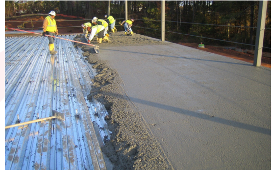
Cubierta de Acero Compuesto
